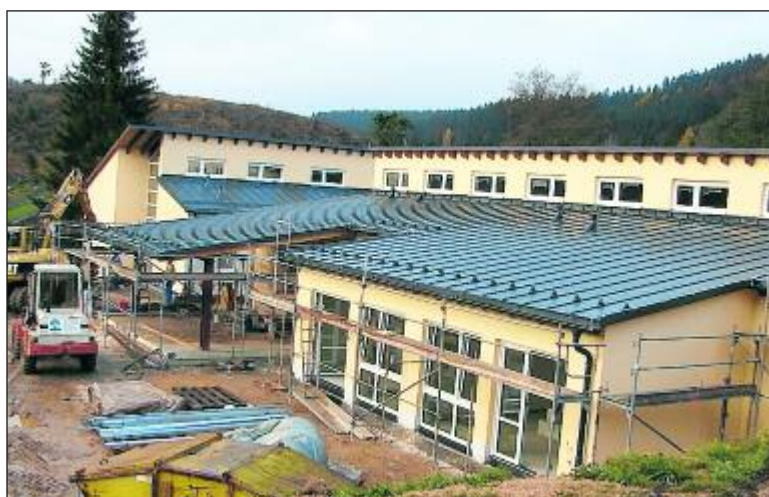
Die Bauarbeiten gehen gut voran. Im Januar soll das Erzgebirgs-Hospiz der Kliniken Erlabrunn gGmbH seine Türen öffnen. Daher startet jetzt ein Aufruf: Gesucht wird ein geeigneter Name für das Haus.
